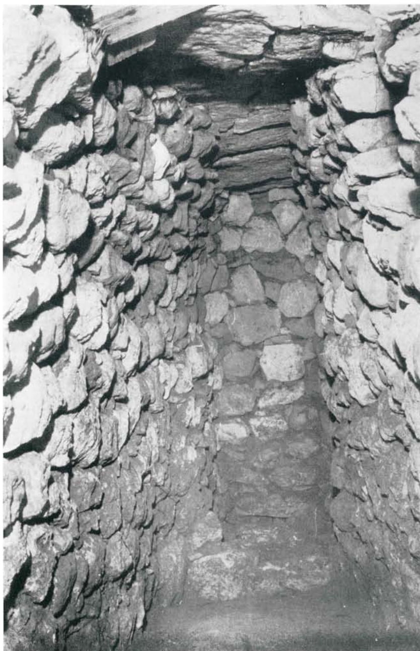
Fig. 30 - Oridda (Sennori). Parte pavimentata della camera.
